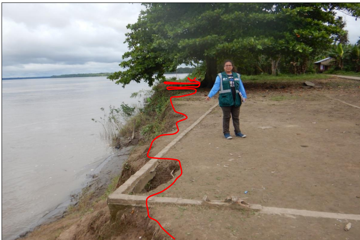
FIGURA N°02: RESTOS DE UNA INFRAESTRUCTURA REUBICADA DEBIDO A QUE FUÉ ALCANZADA Y AFECTADA POR LA EROSIÓN Y PÉRDIDA DE SUELO.
